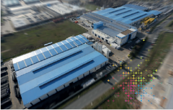
Georg Fischer Hakan Plastik Çerkezköy Üretim Tesisleri
